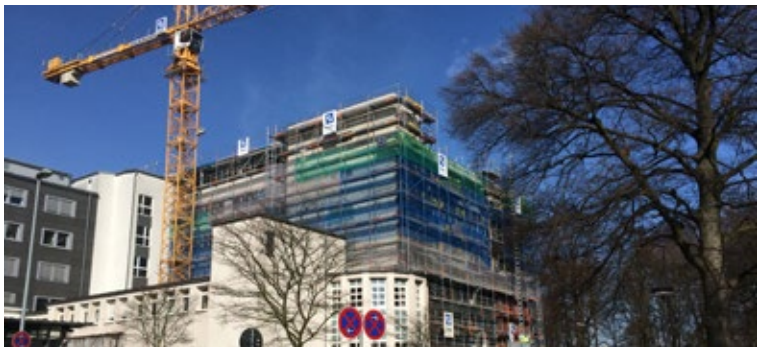
Schlüsselfertigbau, Aufstockung Bergmannsheil Gelsenkirchen
