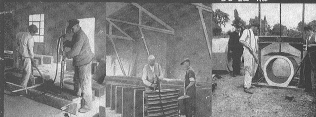
Stampfen v. Betonstufen
